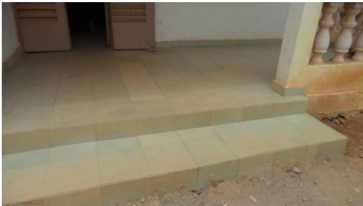
Qualité bas de gamme des carreaux (multicolores)
