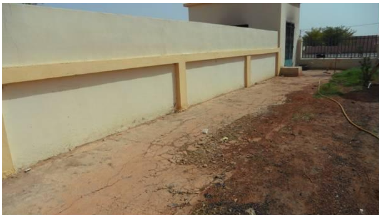
Finition approximative de dallage sol pour circulation véhicules
