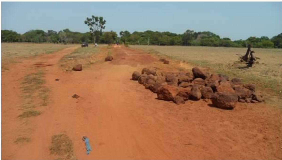
Noter la déviation créée par les usagers et le reprofilage de la route avec création fossés
