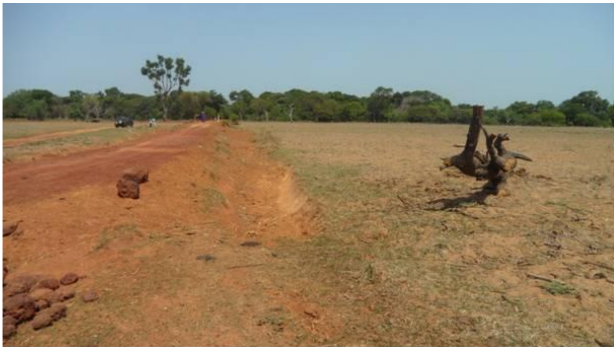
Noter la déviation créée par les usagers et le reprofilage de la route avec création fossés
