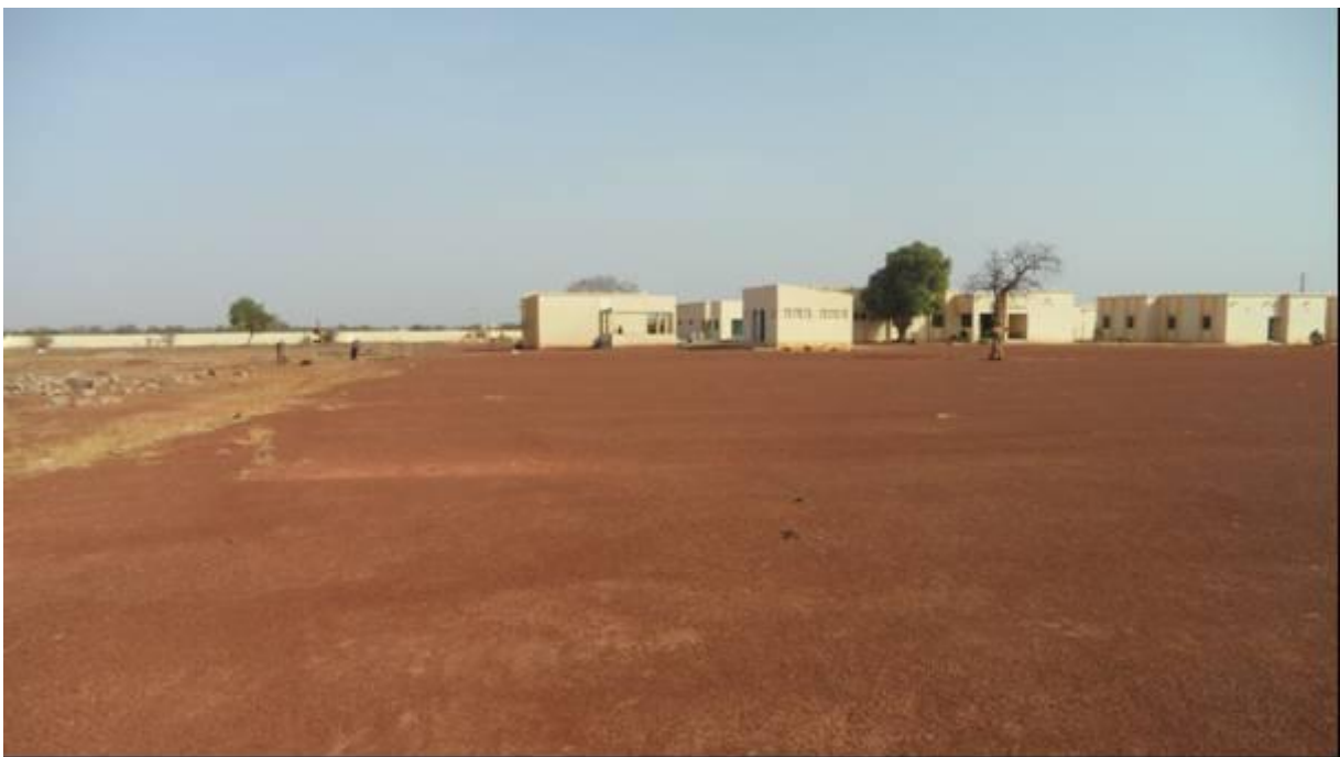
Domaine du remblai latéritique pour avenant
