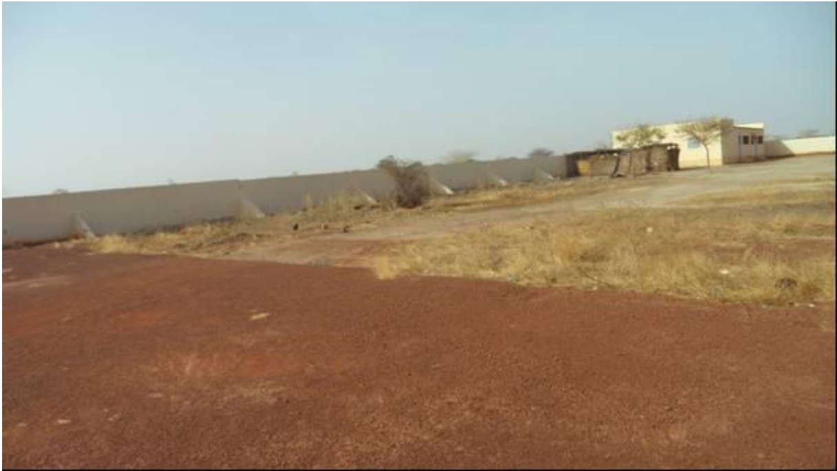
Domaine du remblai latéritique pour avenant
