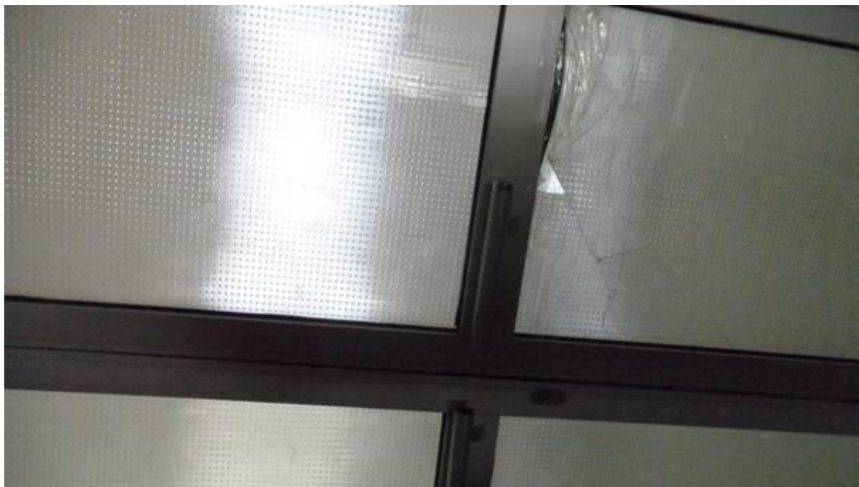
Vitre cassée porte va et vient du bloc opératoire
