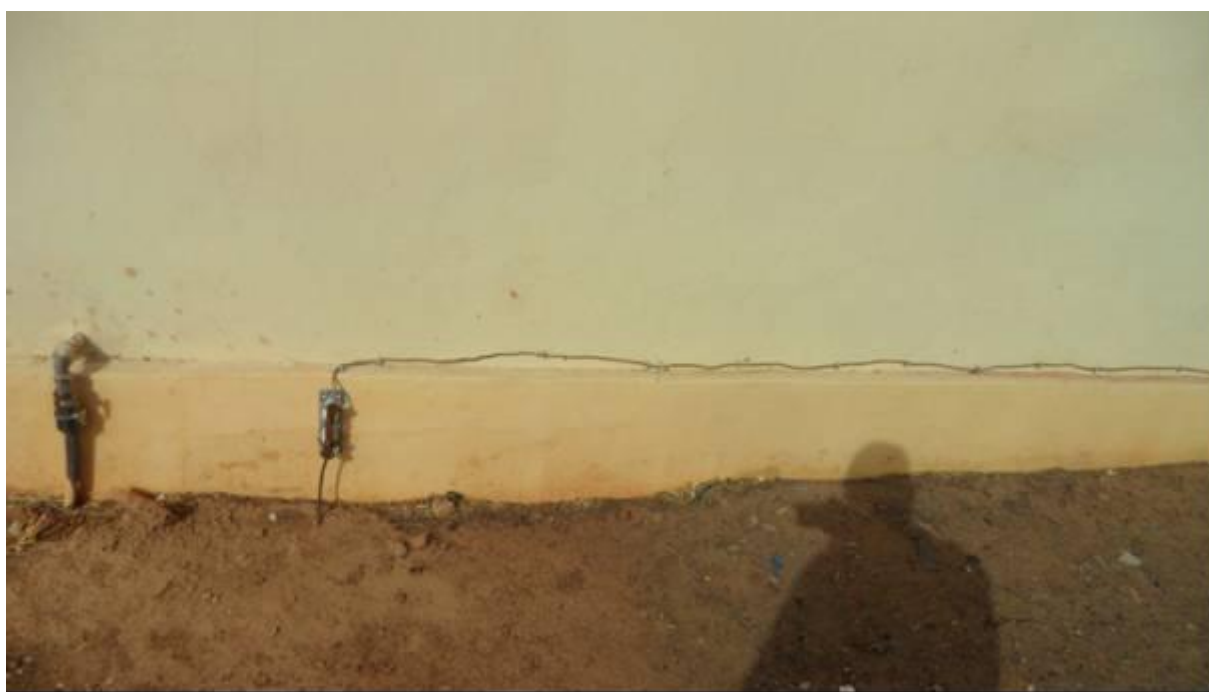
Mise à terre d'un bloc (bâtiment)
