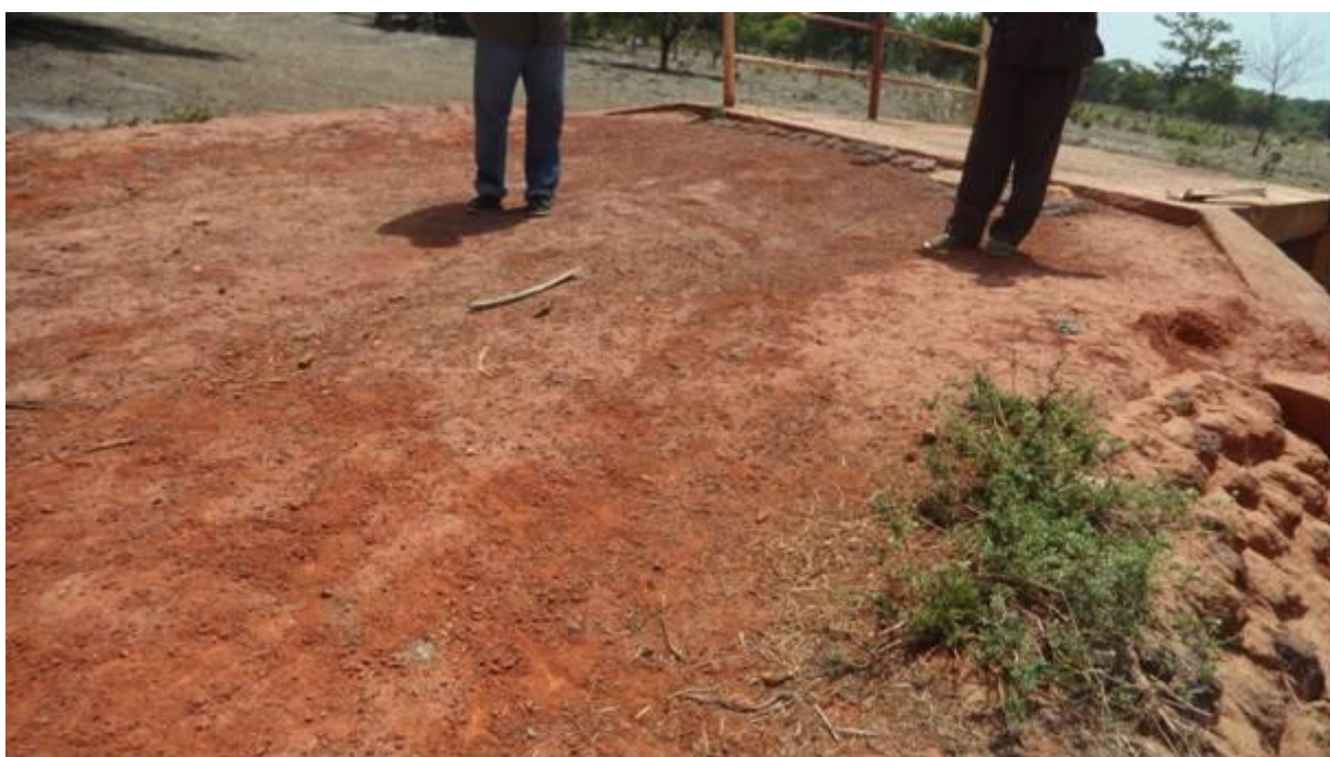
Etat des ouvrages non circulés
