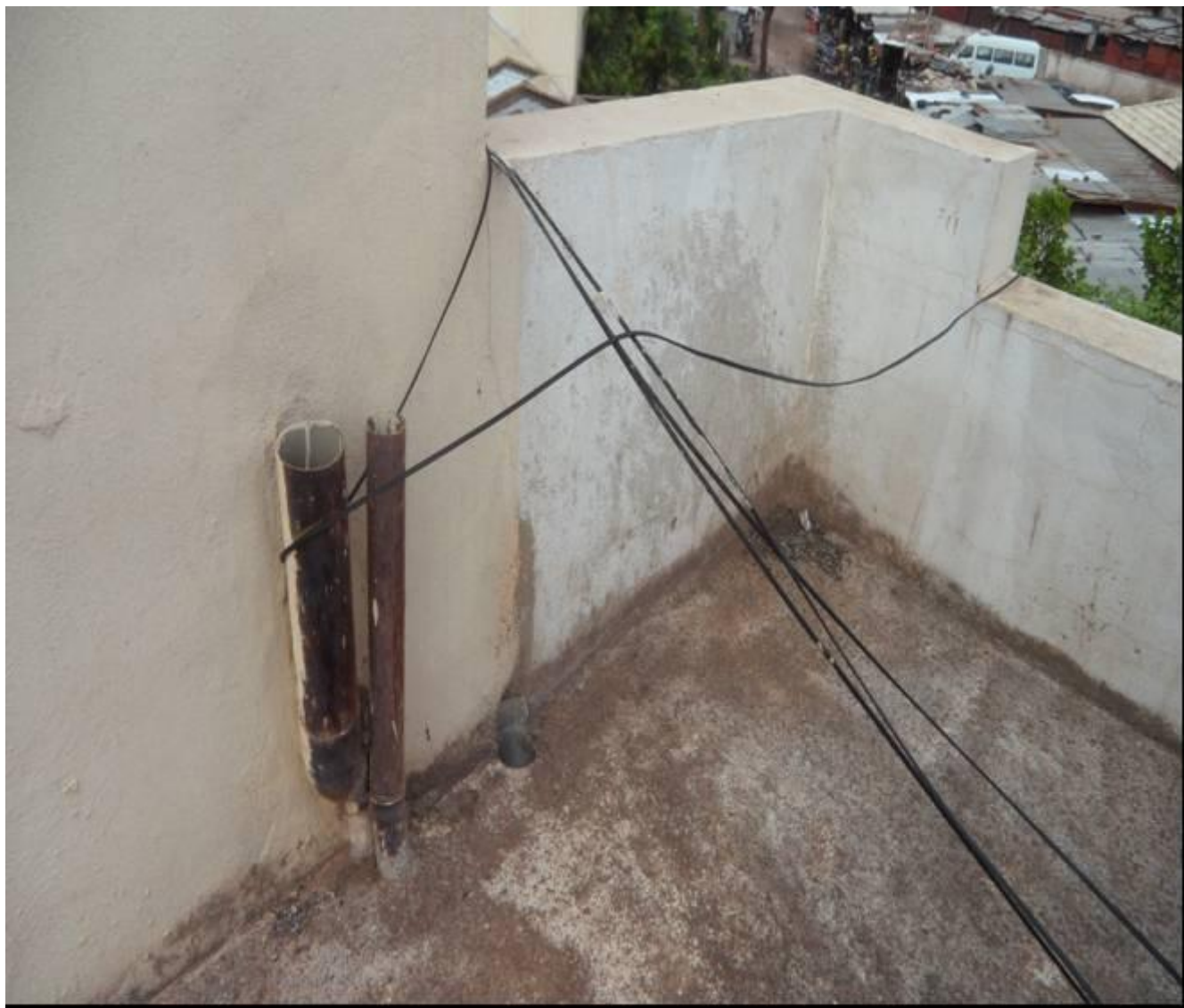
Réceptacle d'eau (entrée) en PVC de 75 (trop faible pour évacuer rapidement eau pluviale)
