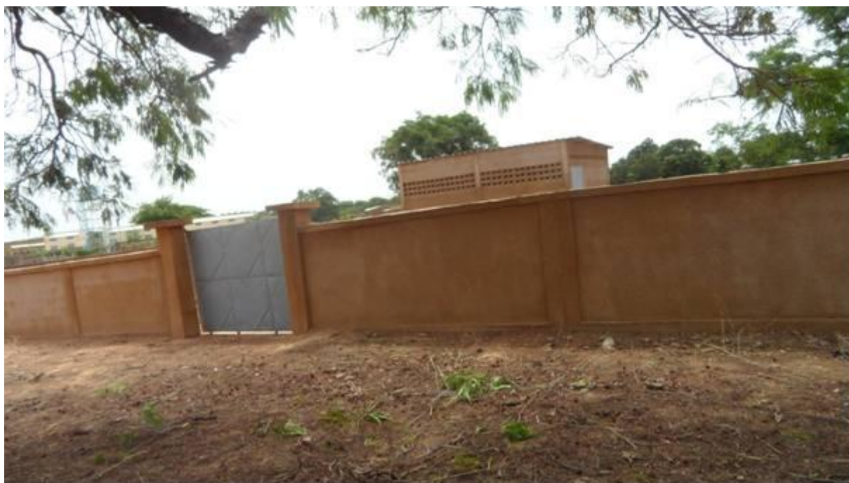
Clôture de l'avenant, noter présence de poteaux raidisseurs
