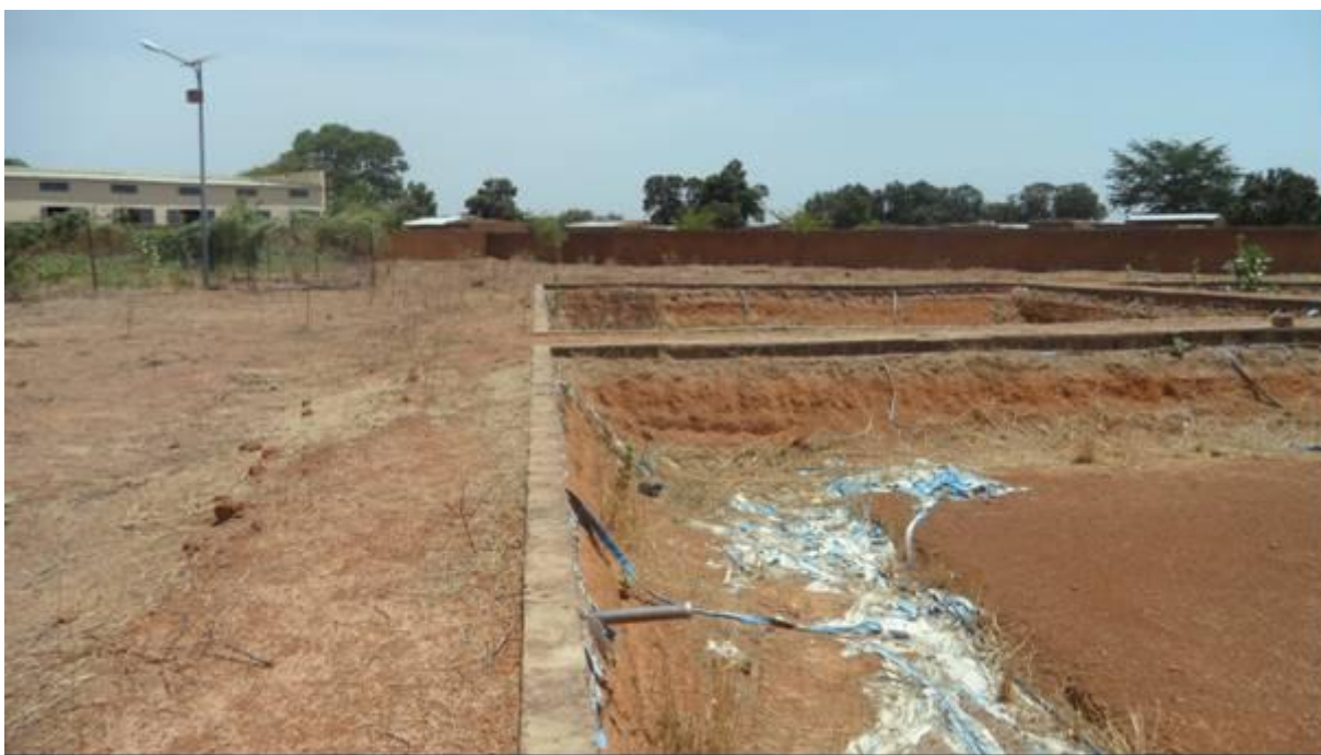
Bassins piscicoles abandonnés avec les bâches à eau fondues
