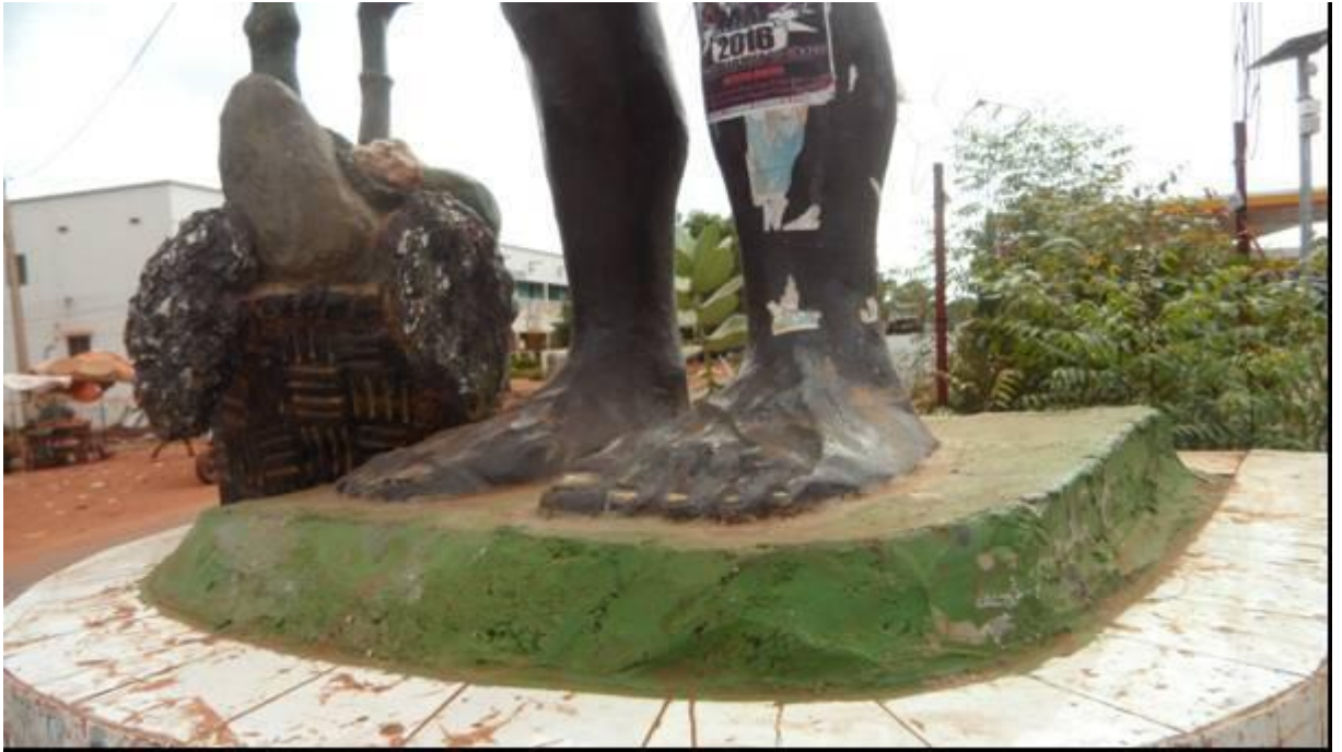
Finition approximative au raccordement entre le socle et le paysan
