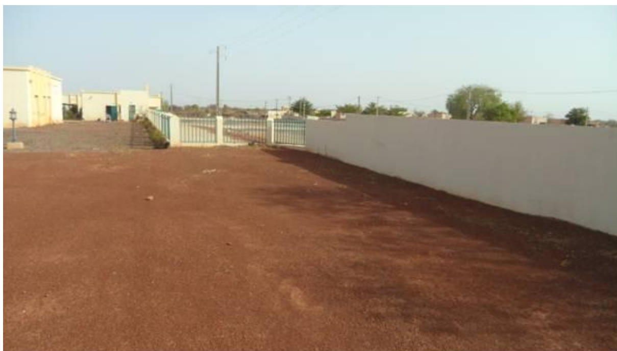
Domaine du remblai latéritique pour avenant
