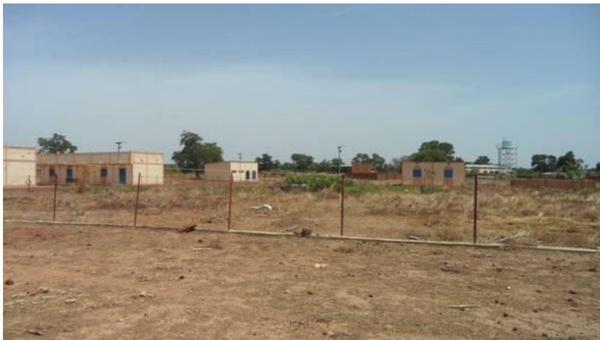
Réalisation de clôture (non prévue) pour le jardin et non réalisation de planches de culture (prévues) pour le jardin
