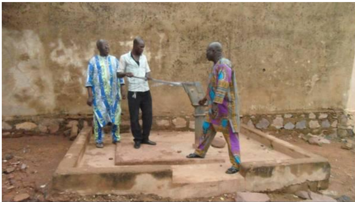
Forage avec pompe défectueuse
