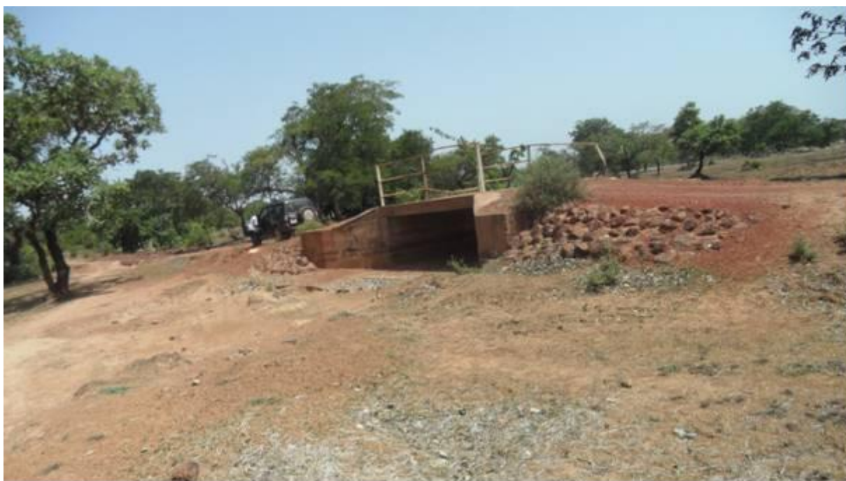
Faible quantité de remblai
