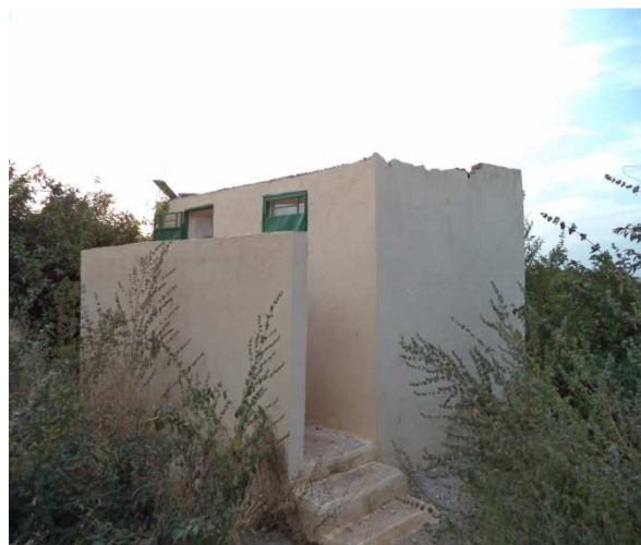
Poste de Tienfala
