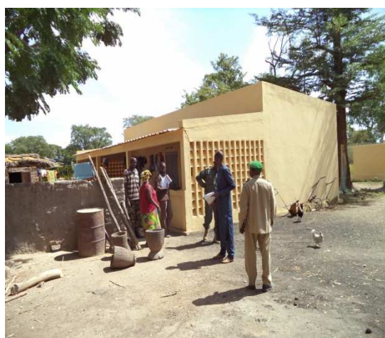
Poste réhabilité de Koblè/N'Tarla
