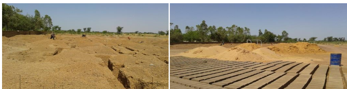
Images des travaux de creusement de la fondation du bloc administratif.
