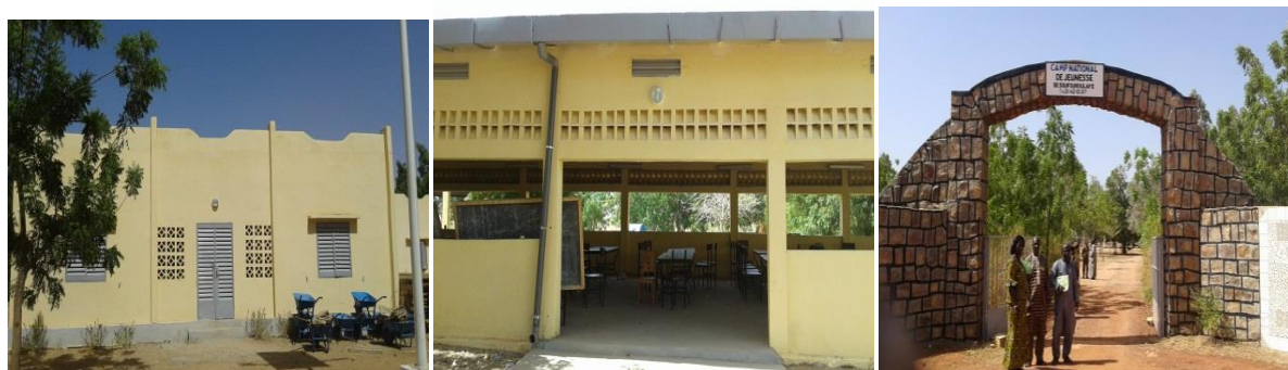
Images des bâtiments et hangar réhabilités par le projet PNUD Jeunesse et Résilience
