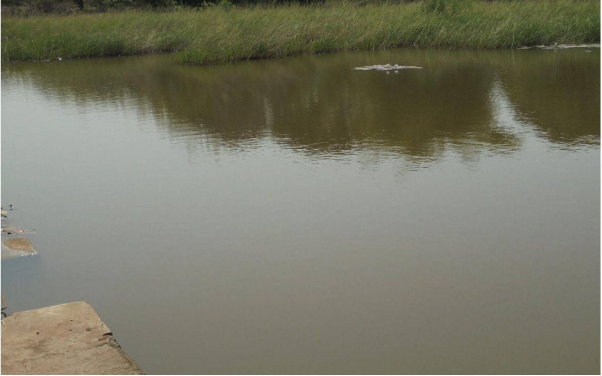
Barrage retenu d'eau
