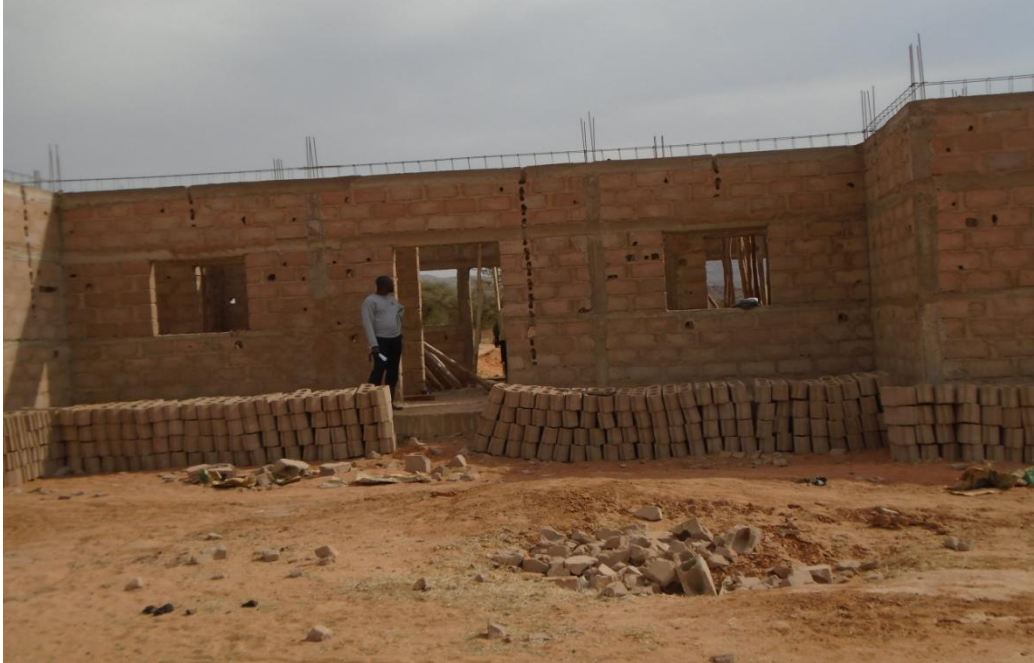
Le SLPSIAP en chantier
