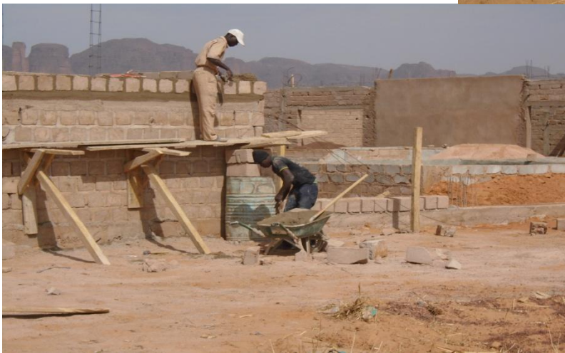
La prison de Dtza en chantier
