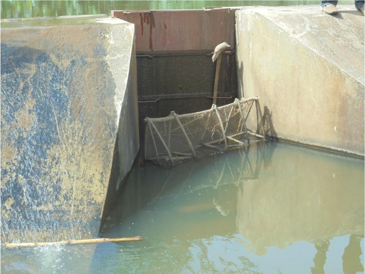
Barrage retenu d'eau
