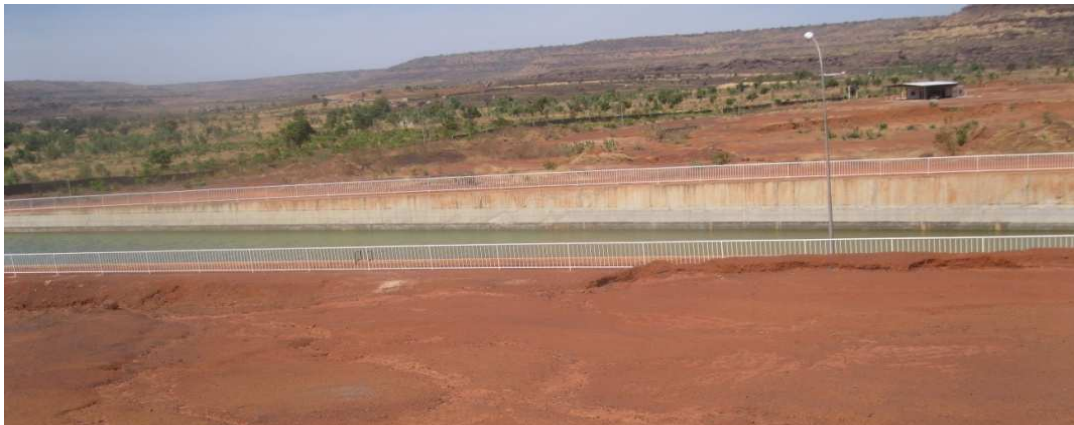
Bassin de lixiviats rempli d'eau pluviale
