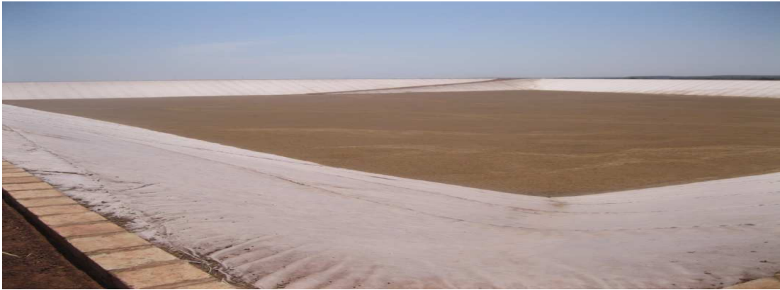
Vue de la Cellule A
