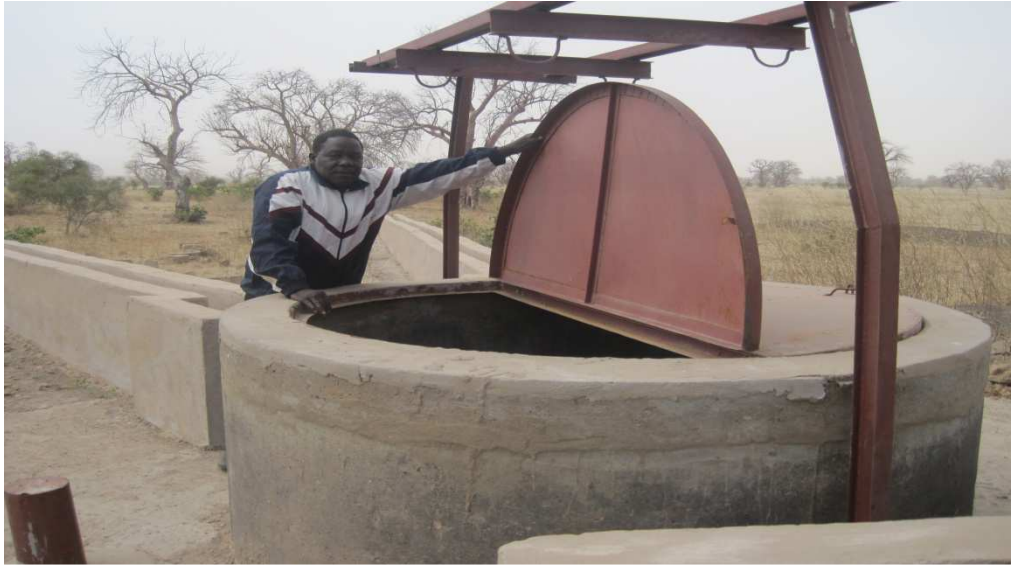
Puits pastoral de Kirewané, la mauvaise qualité des piliers de la poulie a été signalée dans les réserves formulées
