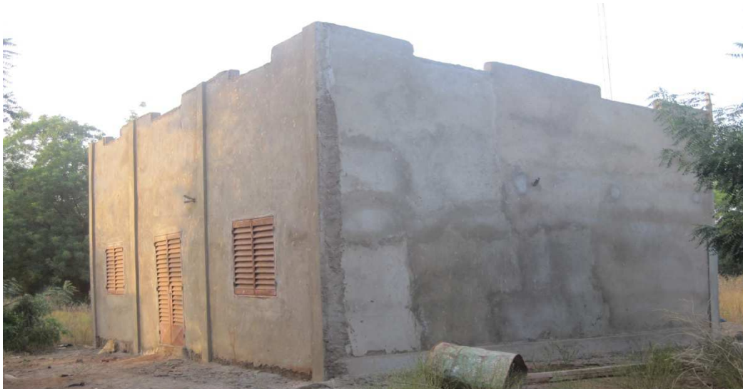
UAPIA centrale de Bafoulabé, arrêtée au niveau des travaux de finition
