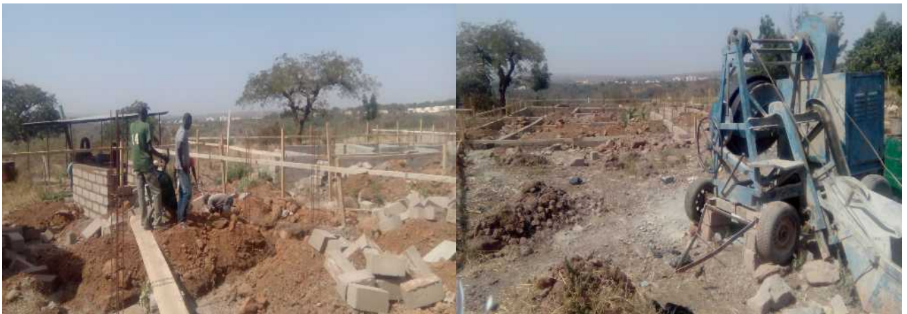
Travaux d'extension des bureaux du CRLD
