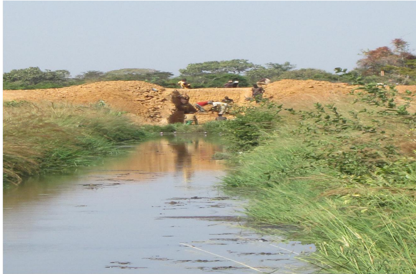
L'Exutoire en chantier
