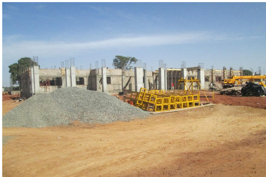
L'IUFP EN CHANTIER
