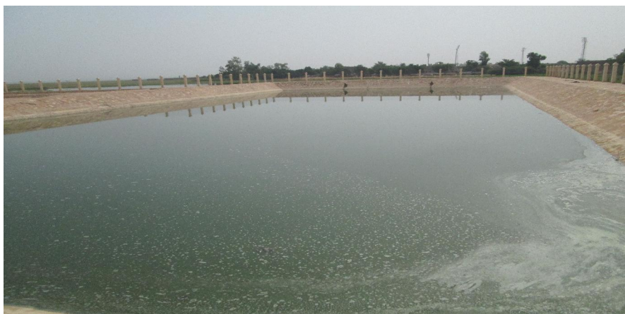
Le bassin anaérobique
