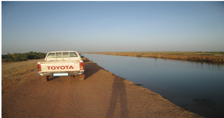
Vue du canal
