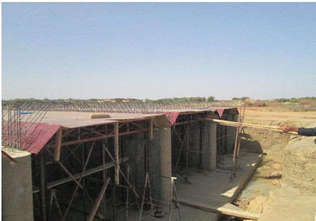
Le Distributeur en chantier
