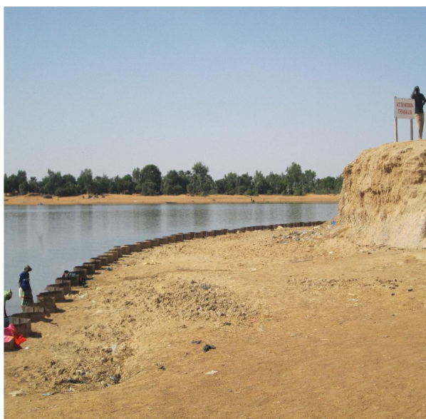
Une vue des travaux de protection réalisés sur les berges
