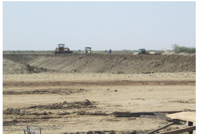
Le Drain principal en construction
