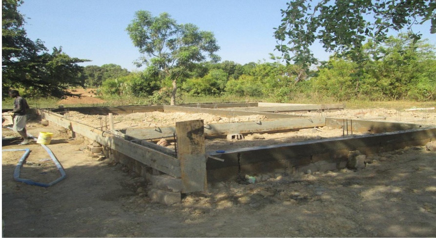
Le Bloc administratif en chantier
