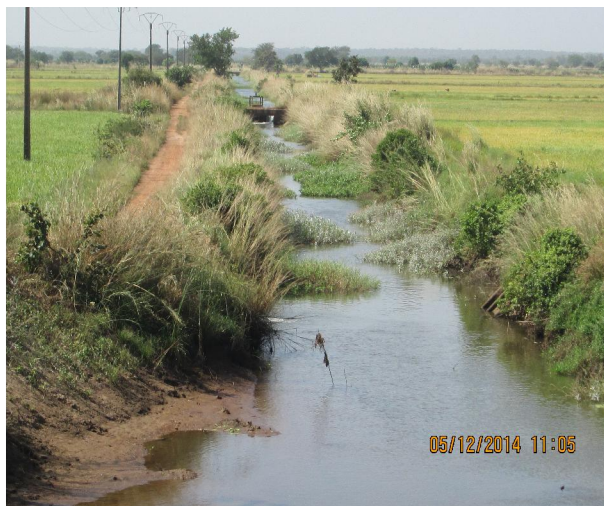
Vue du drain principal
