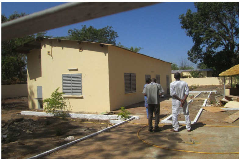
Le logement du Chef personnel en rénovation
